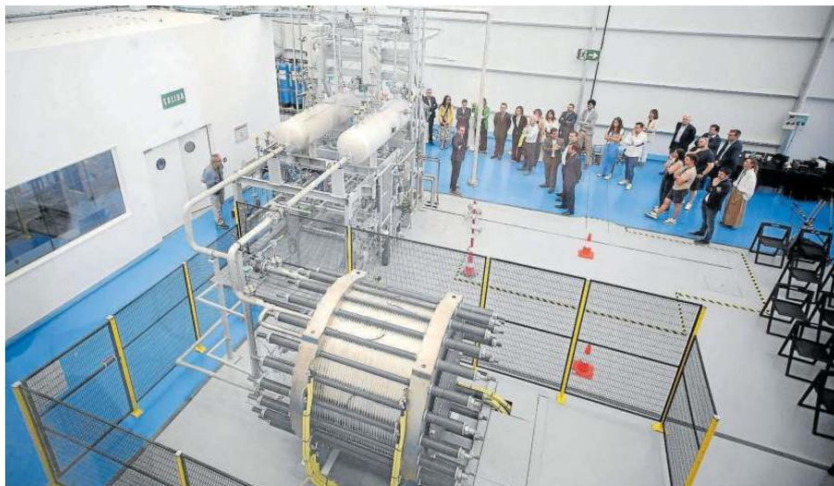
Un grupo de invitados atiende las explicaciones sobre el funcionamiento del electrolizador, bautizado como 'Micaela'. Foto: Javier Bergasa
