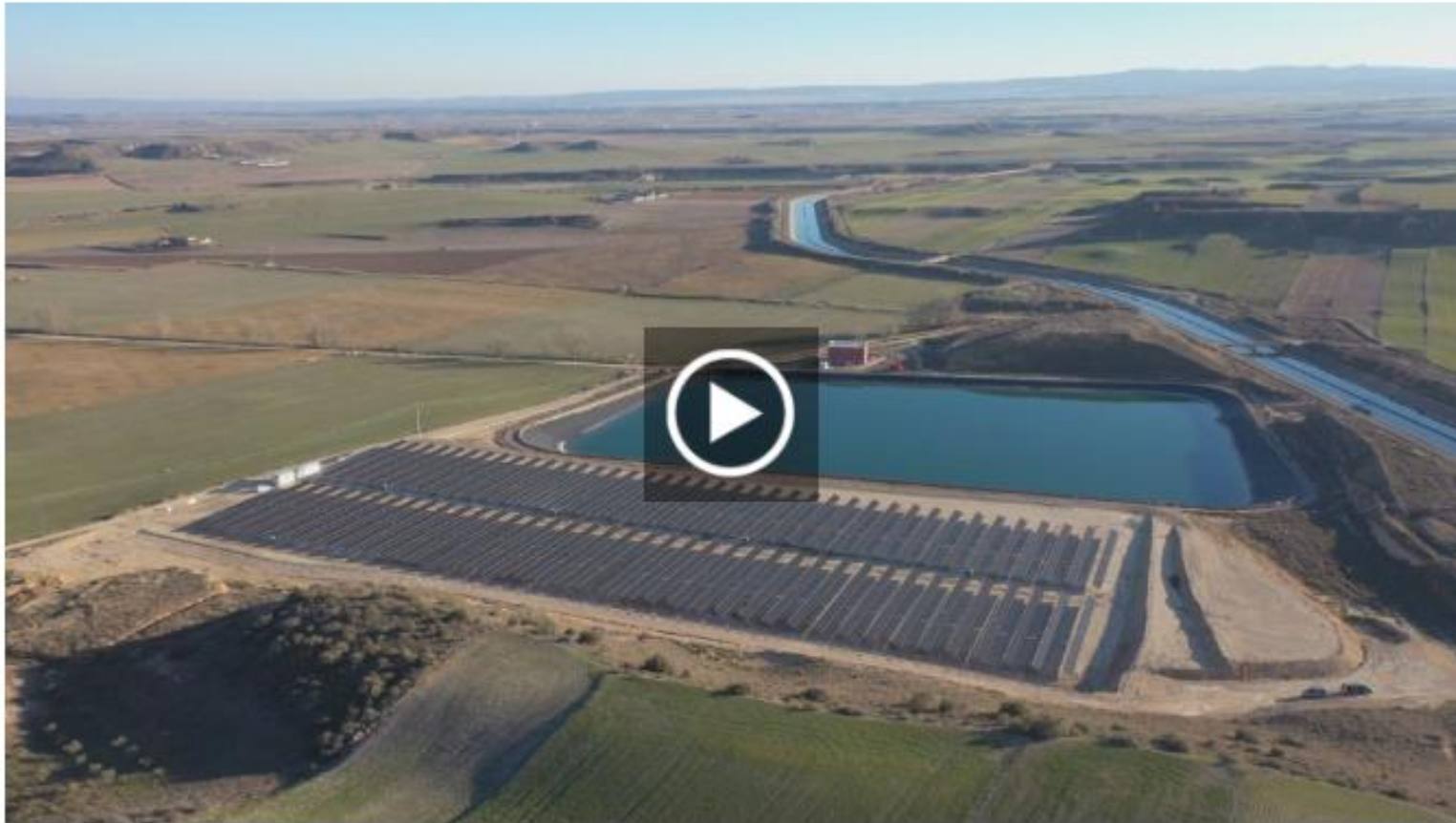
Imagen aérea del sistema fotovoltaico de la comunidad de regantes de Montesúsín
