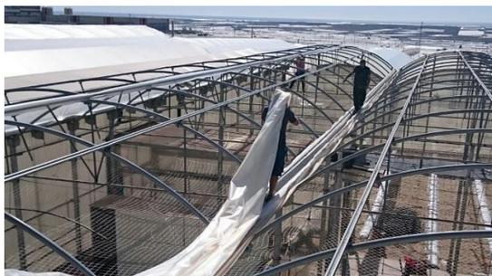
Figura 7. Operarios cambiando los plásticos de un invernadero.
