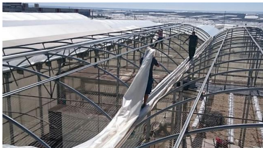
Figura 7. Operarios cambiando los plásticos de un invernadero.
